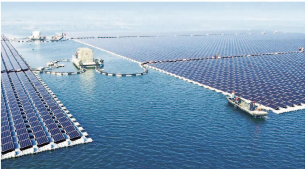
**Figura 4.** Pannelli fotovoltaici off-shore
